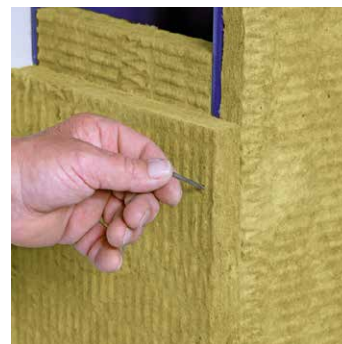
Fissaggio del rivestimento antincendio con perni metallici finché si è seccato l'adesivo (fino a 12 ore).
