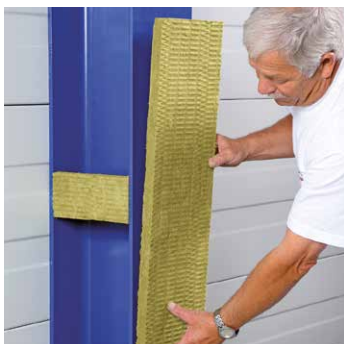
Applicazione del rivestimento antincendio sul davanti
