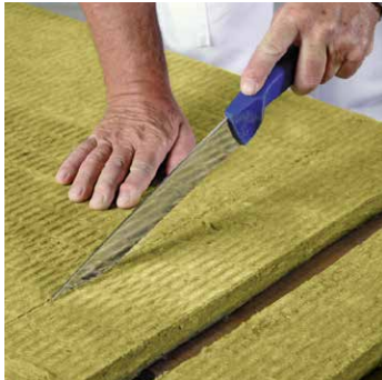
Taglio su misura dei pannelli
