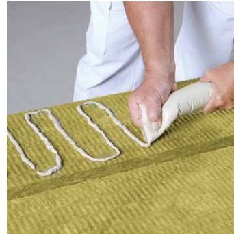
Applicazione di Conlit® Fix sul rivestimento (con un cordone adesivo)
