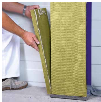
Applicazione del rivestimento antincendio sulla flangia laterale
